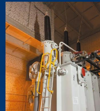
НА ОБЪЕКТЕ ЗАМЕНИЛИ СИЛОВОЙ ТРАНСФОРМАТОР 110 КВ, УСТАНОВИЛИ СОВРЕМЕННЫЙ КОМПЛЕКС РЕЛЕЙНОЙ ЗАЩИТЫ И АВТОМАТИКИ.
